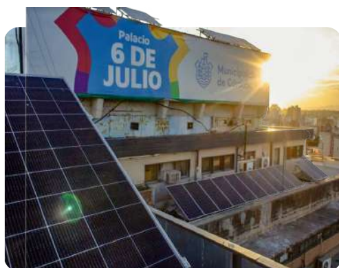
Palacio "6 de Julio", edificio central de la Municipalidad de Córdoba, se alimenta con energía solar que se almacena a través de equipos específicos para tal fin.
